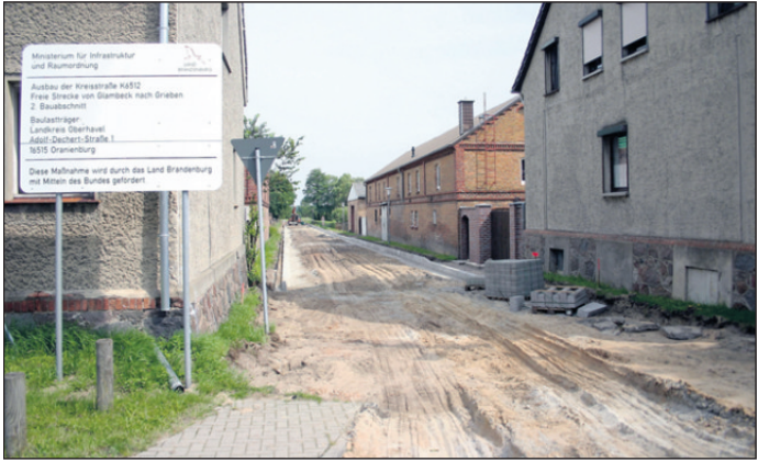
Die Tragschicht der Straße wird vorbereitet.
