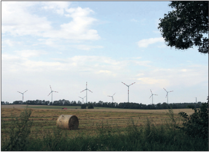
Zwischen die acht bestehenden Windräder will der Betreiber Energiequelle drei höhere Anlagen bauen.
